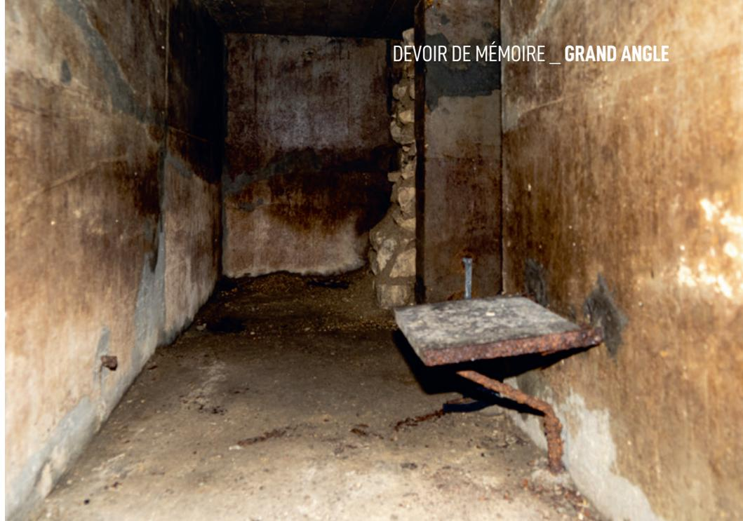
C'est une succession de couloirs aux murs bétonnés nus, tournant tantôt à gauche ou à droite... Difficile d'y avancer si l'on fait plus de 2 mètres et autrement qu'en file indienne... Au plafond, on peut deviner les vestiges d'un système de ventilation et d'éclairage. À hauteur de genou, encore bien ancrées dans les murs, on reconnaît des fixations en métal sur lesquelles étaient posés des bancs.
